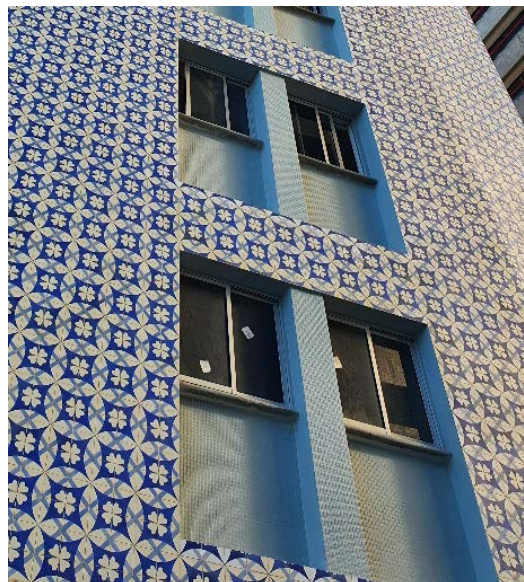
Fig. 6. Fachada Norte e as esquadrias dos banheiros Fonte: o autor.
