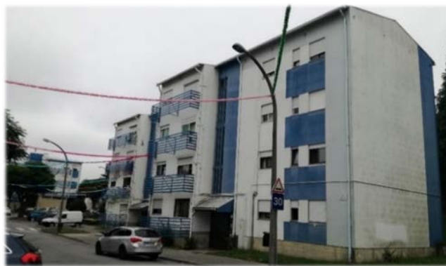
Figura 3 - Fotografia do edifício em estudo
