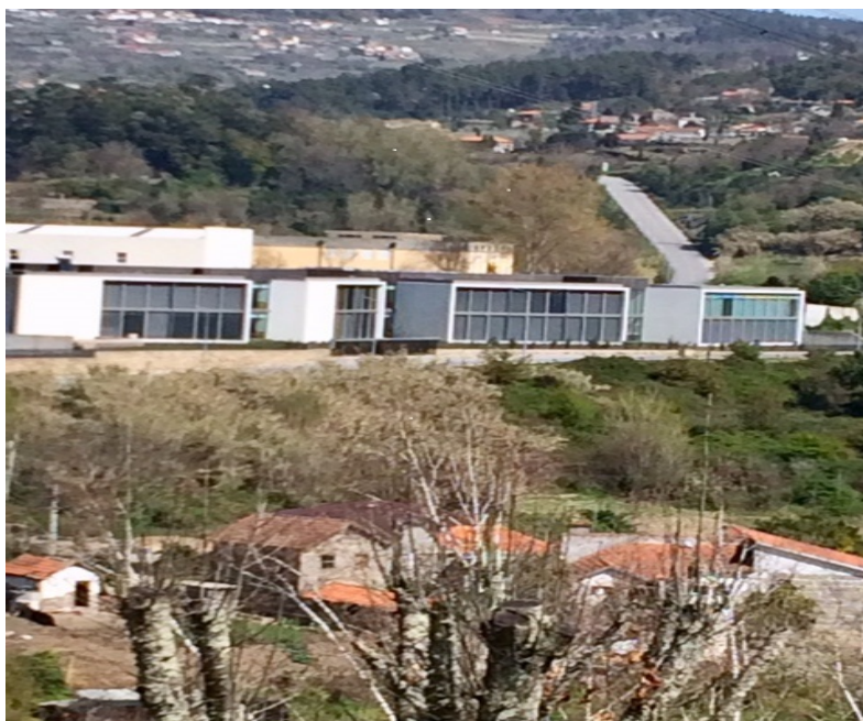
(Fig.1) – Escola da Parque Escolar em Santa Marinha do Zêzere (Baião) orientada a Sul com fachada sombreada pelo interior, isto é, abrindo toda a frente à penetração da radiação que se transforma num painel radiante que aquece o que não seria necessário...e quando não seria necessário.
