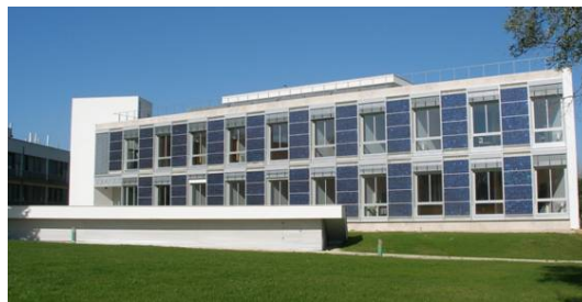
Fig. 1. Edifício Solar XXI
