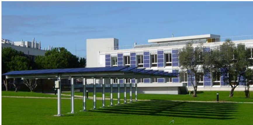
Fig. 1 Plataforma experimental Edifício Solar XXI
