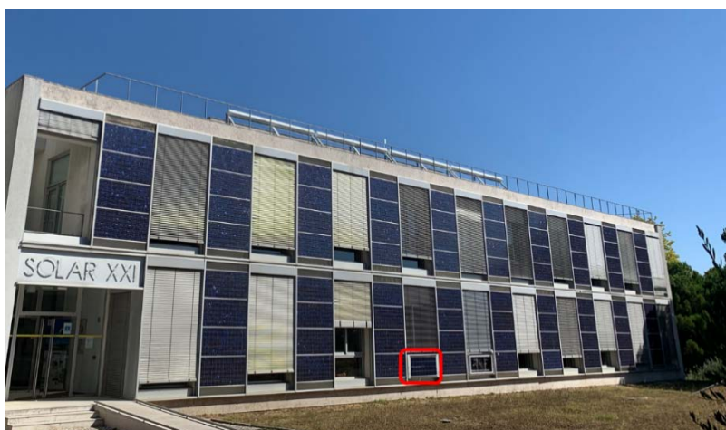
Fig.1 Edifício SolarXXI, integração protótipo BIPV-WS
