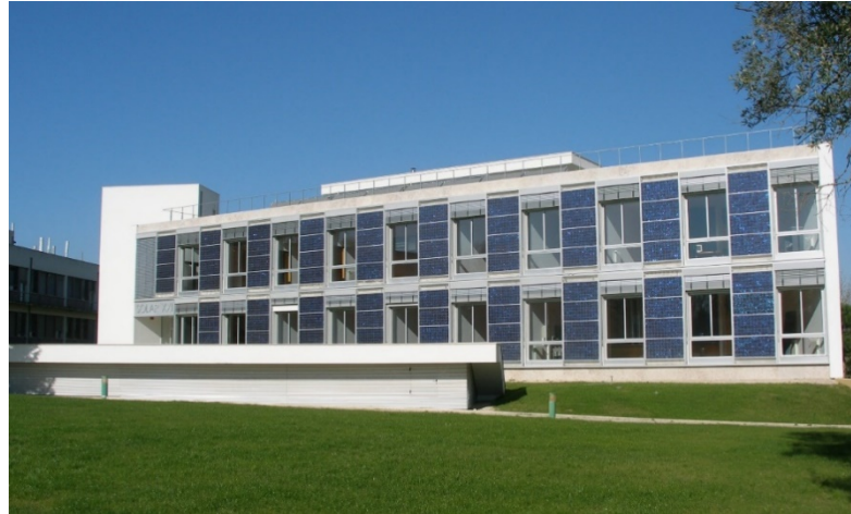
Fig. 1. Edifício Solar XXI
